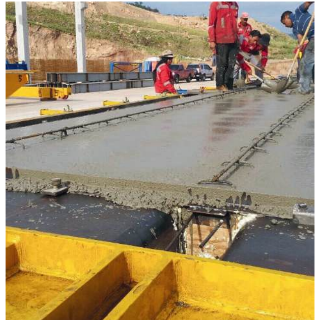
Molde con apertura hidráulica y ajuste hidráulico de altura de costilla.
