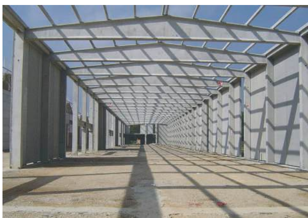
Edificio industrial con correas sobre viga Delta
