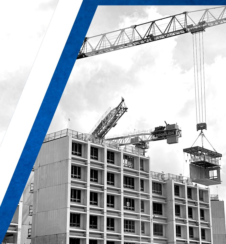
**CONSTRUCCIÓN VOLUMÉTRICA PREFABRICADA
